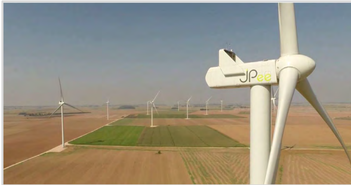
PHOTO 1 - PHOTOGRAPHIE DU PARC EOLIEN DU MOULIN D'EMANVILLE
